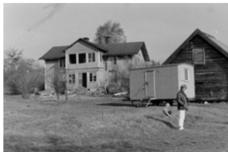
Rivning av Norrgården 1969. ORIGINAL: FAMILJEN BJÖRK
