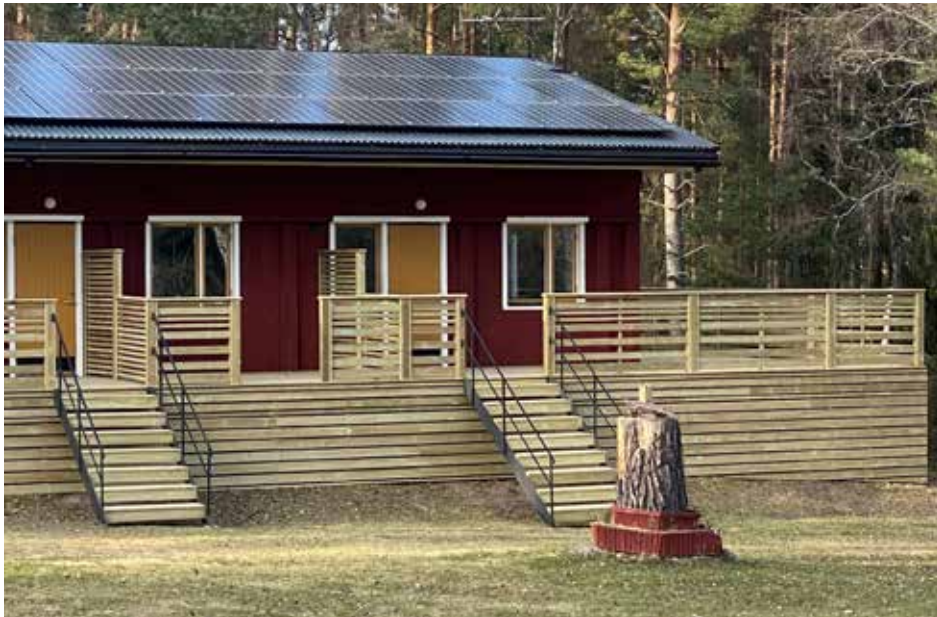
Adelsögården har nu byggts om till 25 bostadsrätter. FOTO: MÅKLARRINGEN
