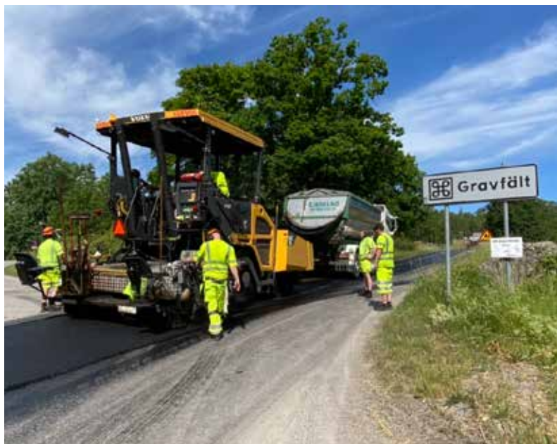
Beläggningsarbete på Adelsö ringväg pågår. FOTO: PIA MOLIN
