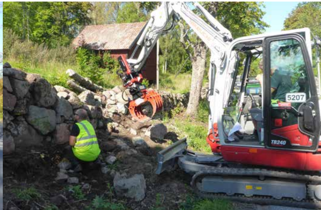
Fredrik Forkelid pusslar varsamt ihop den gamla muren och Staffan Norlin hjälper till med grävskopan. FOTO: LASSE CARLSSON
