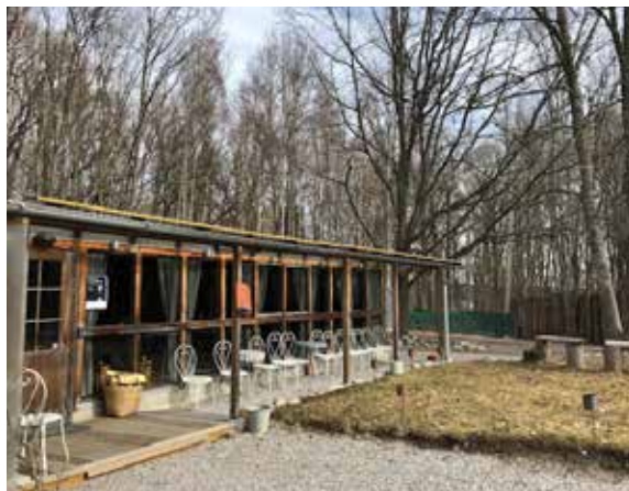
"Pannrummet" var just ett pannrum på gamla Stenby trädgårds tid. FOTO: IRENA LUNDBERG
