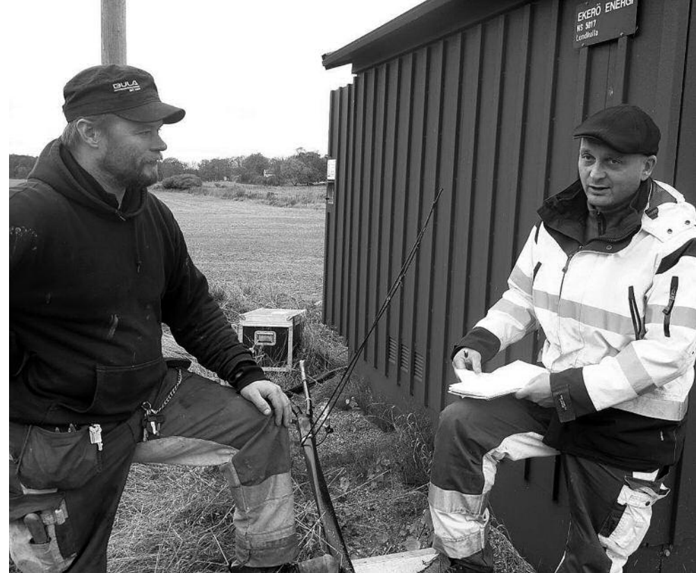
Joakim Sandqvist och Martin Åkerblom från entreprenören One Nordic ansluter jordkablar till transformatorn i Lundkulla.
